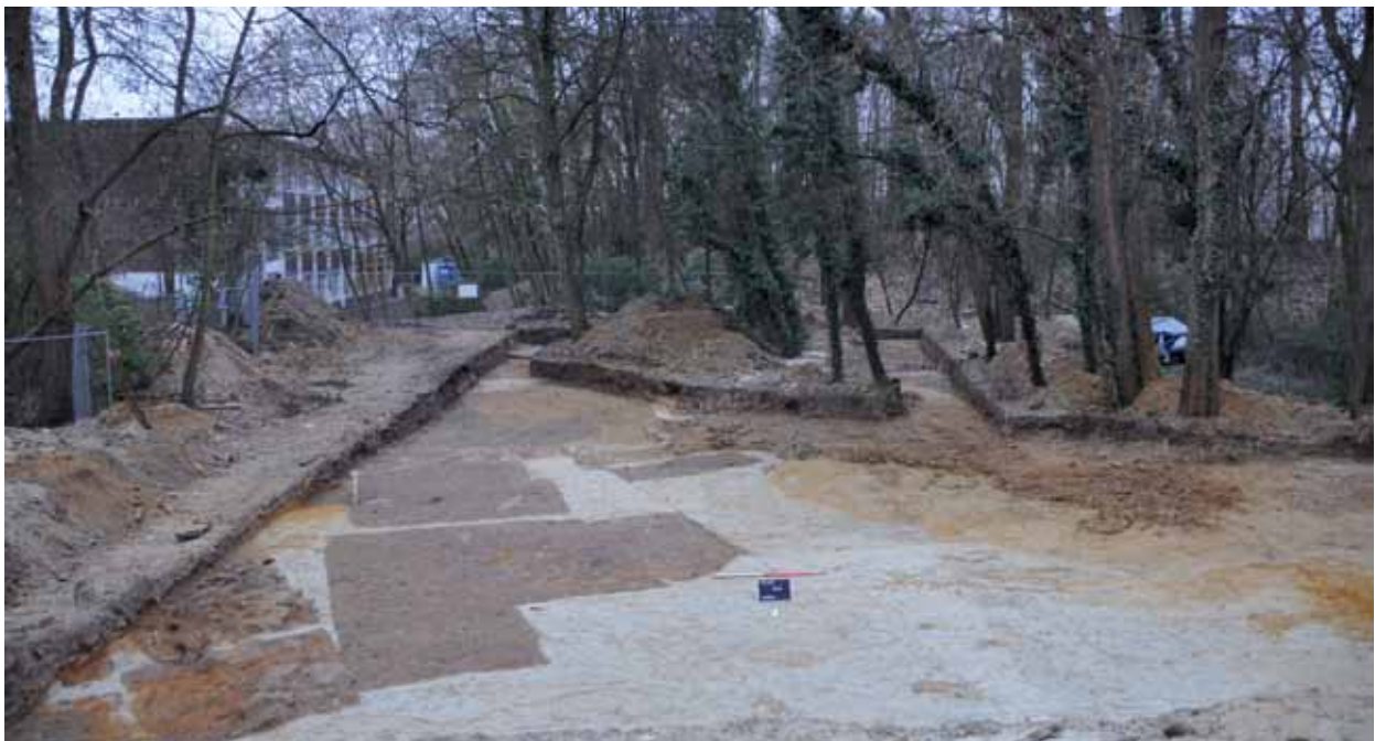
Fig. 1. Uccle-Neckersgat : vue générale du chantier avec les fosses d'extraction de sable modernes. Le site archéologique a été complètement arasé par cette exploitation durant la première moitié du XX e siècle (S. Byl © CReA-Patrimoine/ULB).
